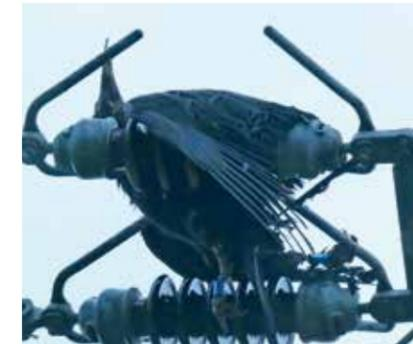
Über ein Drittel der Projektvögel sterben an ungesicherten Strommasten. Die Absicherung dieser Mittelspannungsmasten ist mit Kunststoffkappen recht einfach und bildet einen Projektschwerpunkt, um vor allem die Gefahren am Zugweg zu minimieren.
