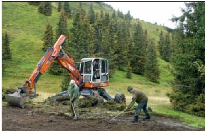
Der Einsatz von schweren Maschinen ist manchmal unumgänglich.
