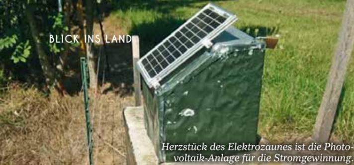
Herzstück des Elektrozaunes ist die Photovoltaik-Anlage für die Stromgewinnung.
